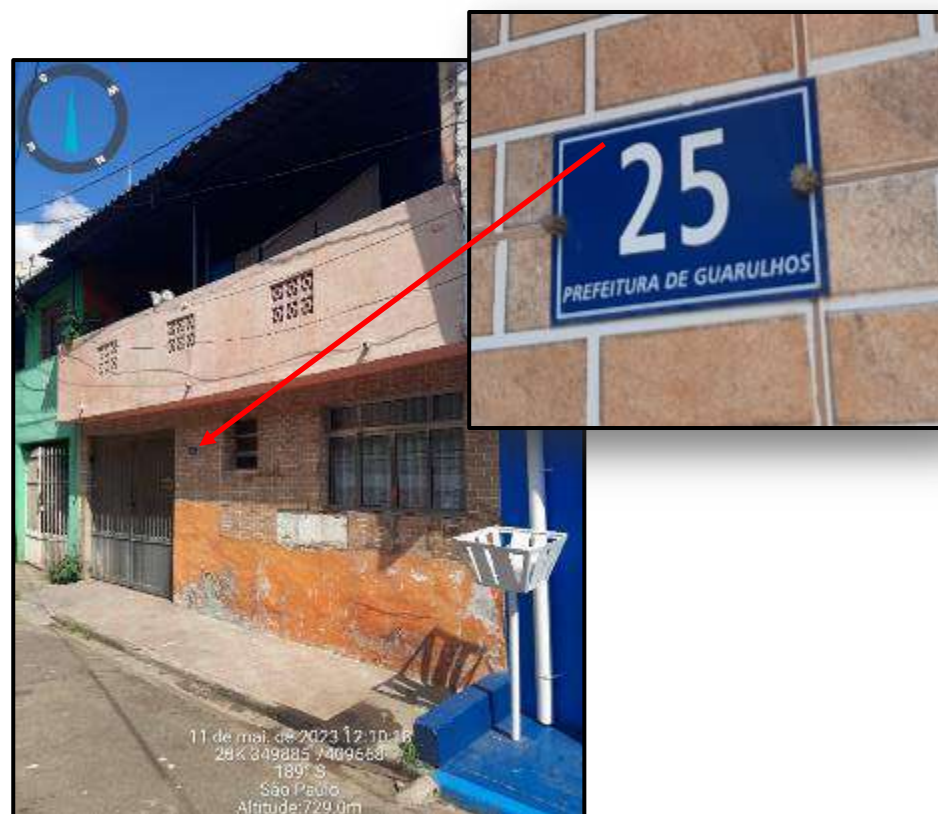
Foto 20: Rua Manoel da Nóbrega nº 25
