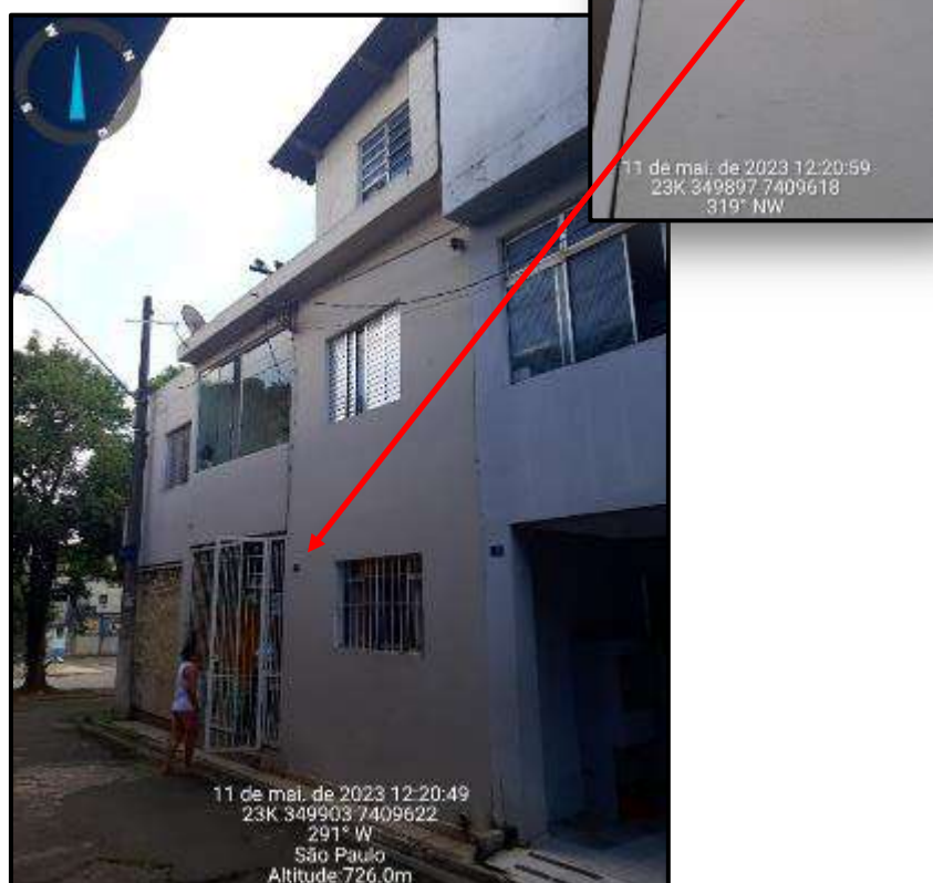
Foto 42: Rua Luiz Davegui nº 11 (proc.1024641-47.2020)
