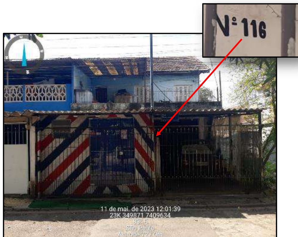
Foto 06: Rua Dino Janeiro nº 116 (proc. 1024631-03.2020)
