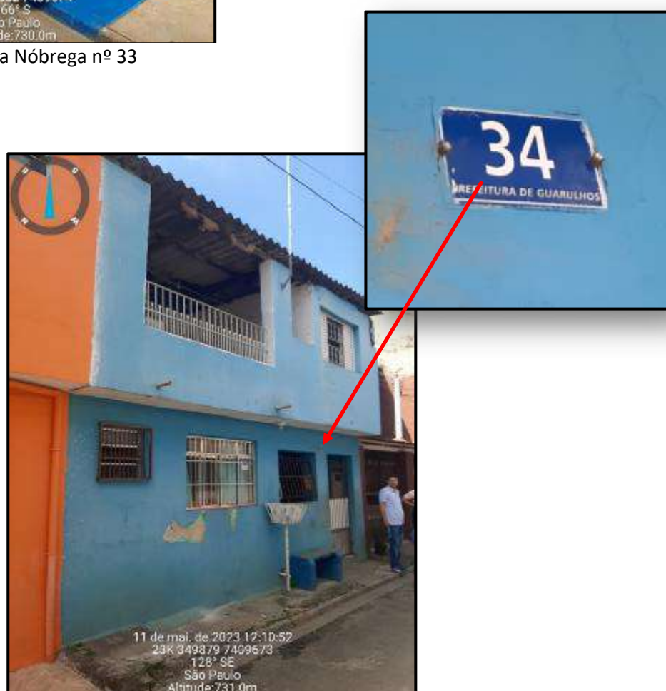
Foto 22: Rua Manoel da Nóbrega nº 34
