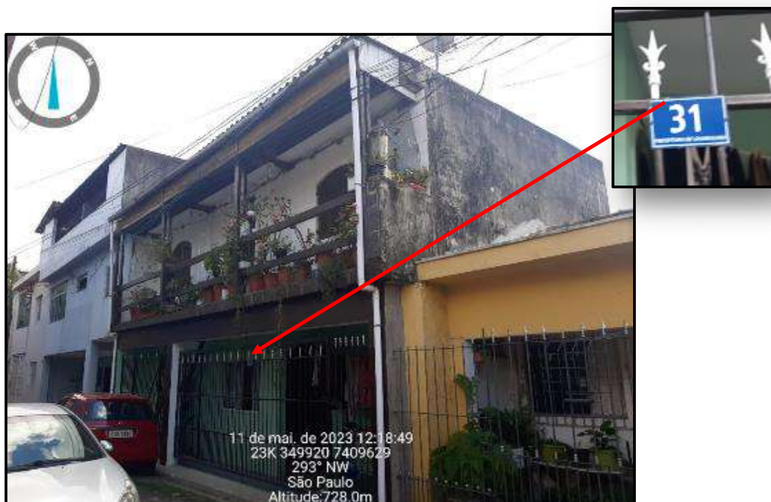
Foto 39: Rua Luiz Davegui nº 31 (proc.1024521-04.2020)
