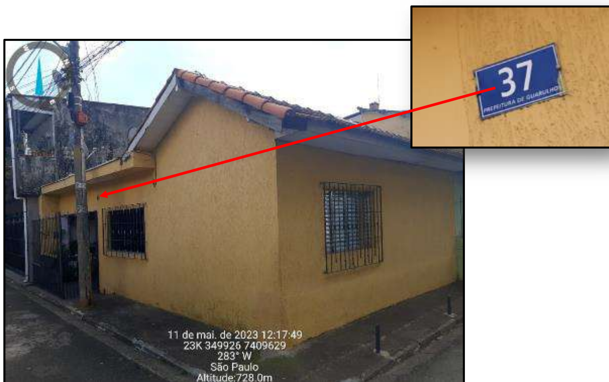
Foto 37: Rua Luiz Davegui nº 37 (proc.1024518-49.2020)
