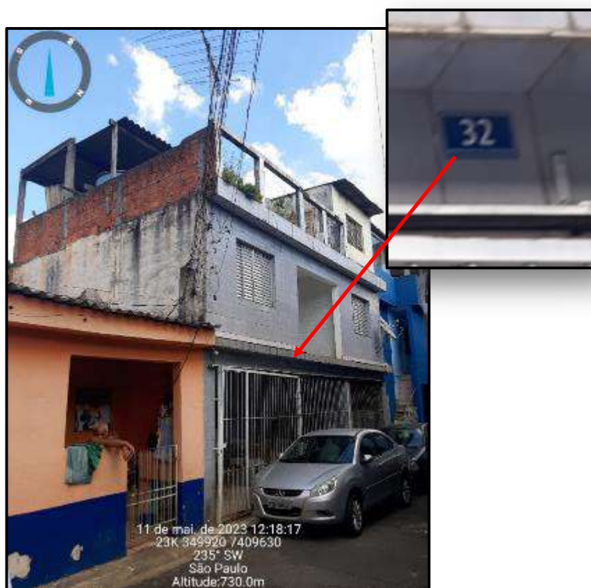
Foto 38: Rua Luiz Davegui nº 32 (proc.1024539-25.2020)
