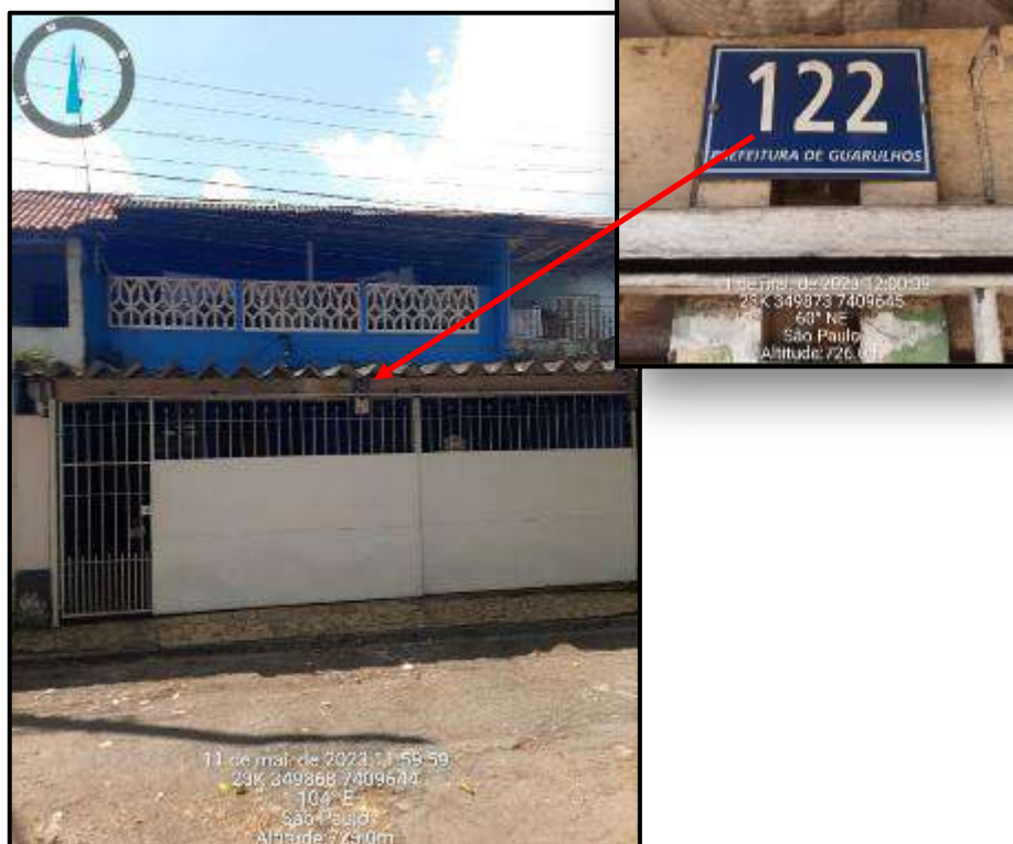
Foto 05: Rua Dino Janeiro nº 122 (proc. 1024582-44.2020)
