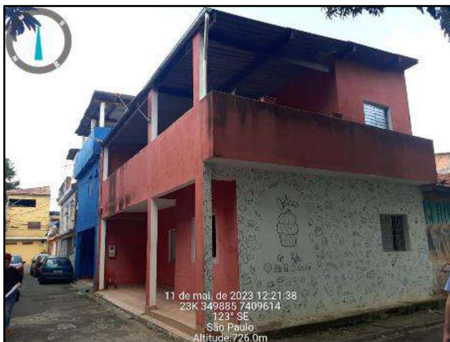
Foto 43: Rua Luiz Davegui nº 14 (proc.1024600-80.2020)
