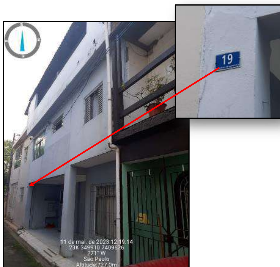
Foto 40: Rua Luiz Davegui nº 19 (proc.1024556-61.2020)
