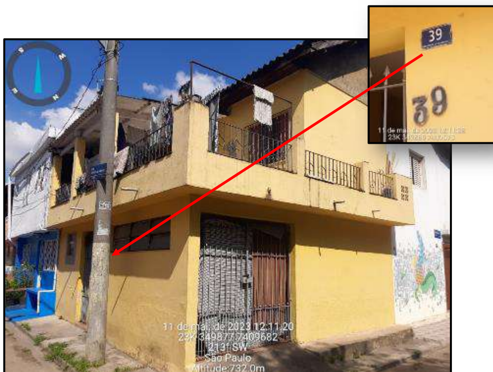
Foto 23: Rua Manoel da Nóbrega nº 39
